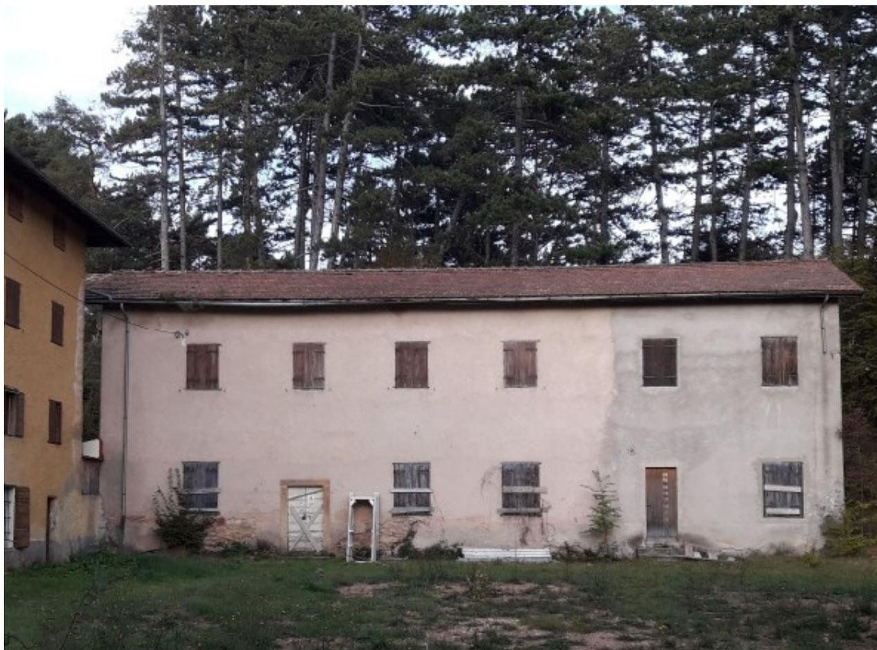
La **p.ed. 918** è un edificio a piano unico, un tempo destinato a teatro e ad attività ricreative, realizzato su pianta regolare in muratura con copertura a falda unica in legno. Anche questo edificio versa in precarie condizioni tali da renderlo inadeguato per qualsiasi funzione. Analogamente alla p.ed. 1167, la variante prevede la possibilità di attuare interventi di ristrutturazione con demolizione e ricostruzione su diverso sedime con le medesime finalità già evidenziate per la p.ed. 1167.
