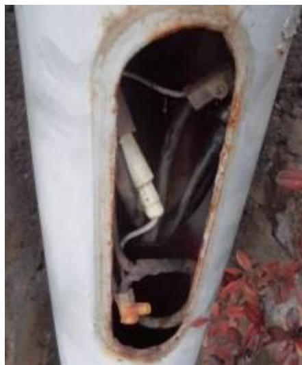
FIGURA 69 – CAVIDOTTI USURATI (FRAZIONE VILLE)
