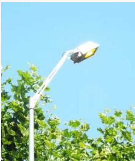
FIGURA 64 – APPARECCHIO NON CORRETTAMENTE ORIENTATO (FRAZIONE VERLA)
