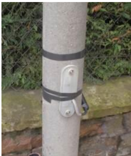
FIGURA 68 – DERIVAZIONE NON CONFORME (FRAZIONE VERLA)
