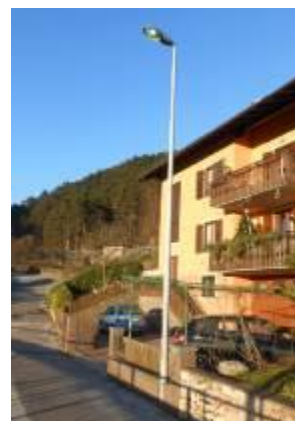
FIGURA 34 – CORPO ILLUMINANTE STRADALE SENZA OTTICA SU PALO VERNICIATO
