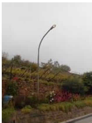
FIGURA 33 – CORPO ILLUMINANTE STRADALE SENZA OTTICA SU PALO CURVO IN CEMENTO
