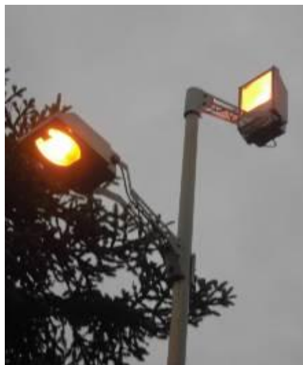
FIGURA 65 – APPARECCHIO NON CORRETTAMENTE ORIENTATO (FRAZIONE VILLE)
