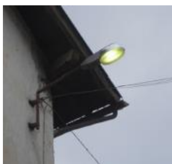
FIGURA 35 – CORPO ILLUMINANTE STRADALE SENZA OTTICA SU MENSOLA
