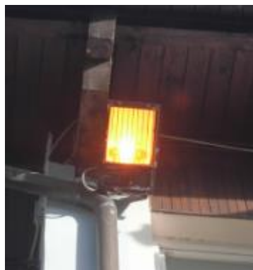
FIGURA 32 – PROIETTORE ASIMMETRICO SOTTOGRONDA
